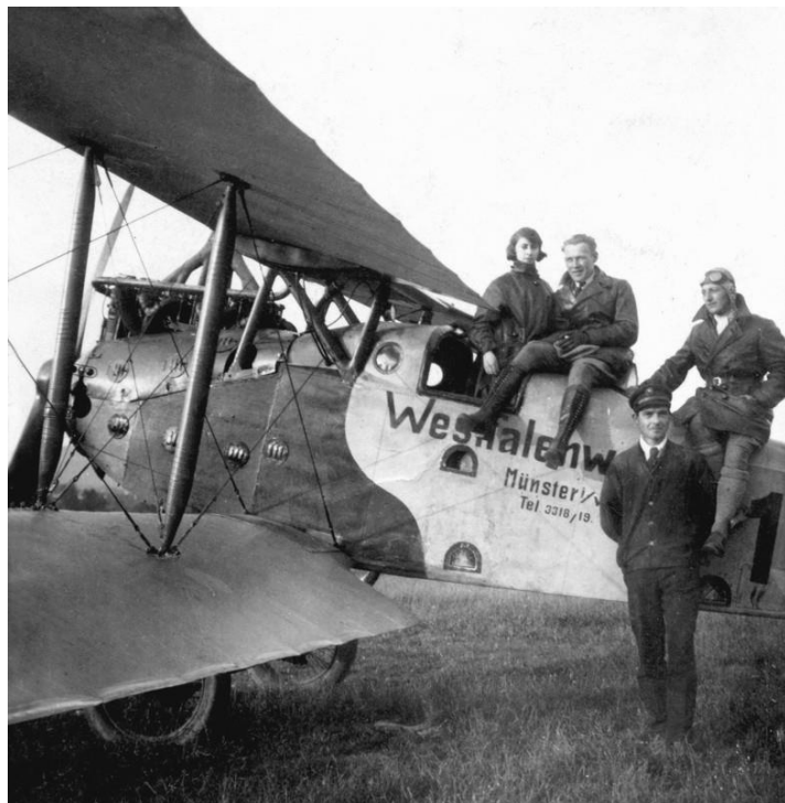
Auf diesem Bild der LVG C VI, D-113, ist die offene Halbkabine für die Passagiere gut zu erkennen. Der Pilot saß dahinter in einem separaten, komplett offenen Cockpit. (Slg. Lange)
