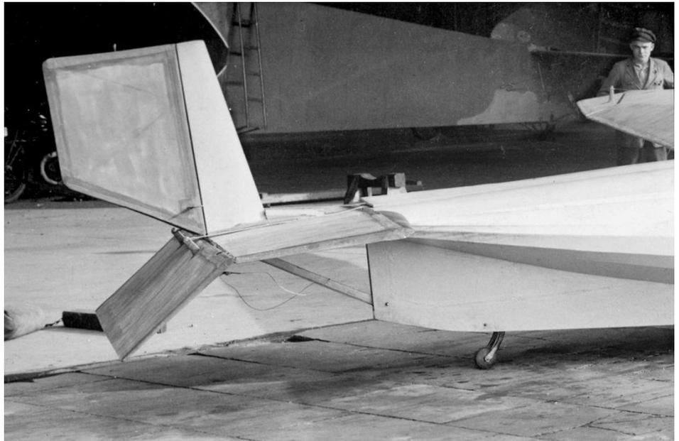
Das Fahrgestell bestand aus zwei Haupträdern, die relativ engspurig im Rumpf unterhalb des Flügels angeordnet waren. Für den Start wurde zwecks Verminderung des Reibungswiderstands ein (abwerfbares ?) Spornrad verwendet.
