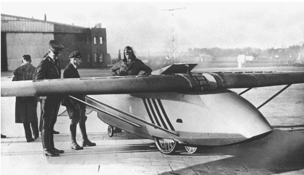
*Volpert-Kompressorflugzeug Nr. 2 während der Erprobung Juli/August 1931 im Flughafen Hamburg-Fuhlsbüttel. Auf der Flügeloberseite sind die Luftabsaugschlitze des Antriebssystems gut erkennbar. Innerhalb der aufgeklappten Nasenverkleidung des Flügelmittelstücks läßt sich das Gehäuse des offenbar quer zur Flugrichtung eingebauten Gebläses ausmachen.*
