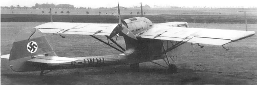
*Zwei Bilder der V2 D-IWHL mit dem neu konstruierten Tragwerk. Das Flugzeug hat jetzt normale Spaltquerruder mit Massenausgleich und entsprechend verkürzte Fowlerklappen. Anstelle der vierflügeligen Luftschraube ist eine mit drei Flügeln eingebaut.
