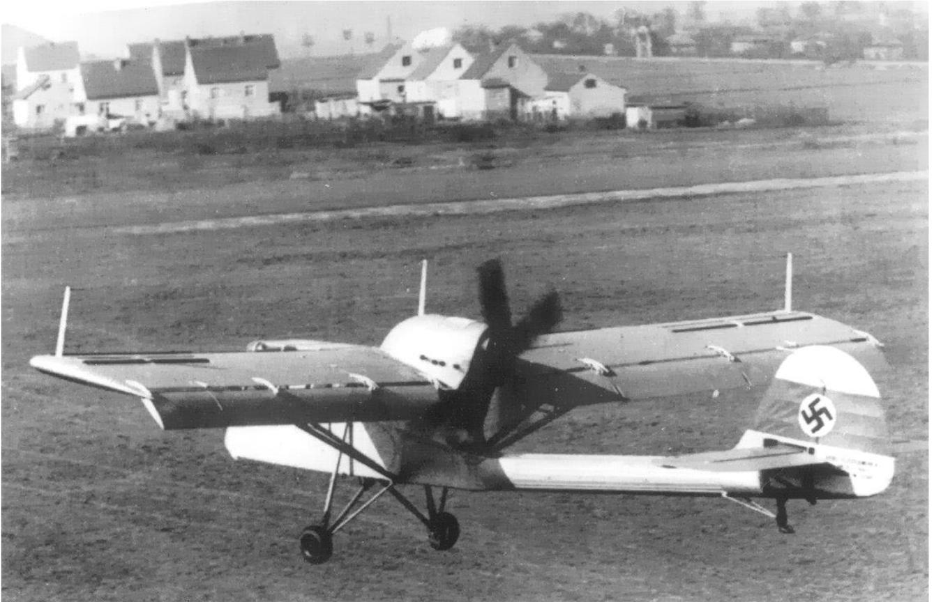
*Flugaufnahme der Si 201 V1 beim Langsamflug bzw. im Landeanflug, mit ausgefahrenen Vorflügeln und Klappen.
