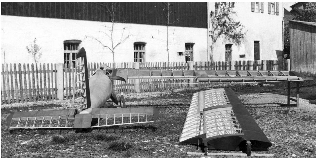
Die „Grane“ im Bau, an den Tragflächen und am Leitwerk fehlt noch die Stoffbespannung. (Marktarchiv Holzkirchen)
