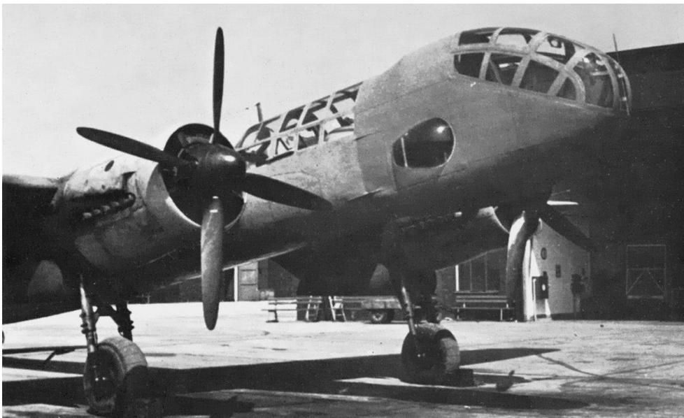
*Die bereits weitgehend der endgültigen Form entsprechende Ausführung der Ju 288-Kanzel, angebaut an die Ju 88 V5. Hier hat das Flugzeug noch sein ursprüngliches, einfaches Leitwerk. Es wurde kurze Zeit später durch das Doppelleitwerk der Ju 288 ersetzt.*
