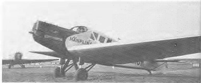
D-ONOR "Hänfling" 1936 mit ungewöhnlicher Lufthansa-Bemalung auf der Insel Wangerooge. Diese Maschine, eine F 13 ke mit hydraulisch gefedertem Fahrgestell und Niederdruckreifen, flog zuvor als I-BAJA bei der italienischen Fluggesellschaft S.A.M.
