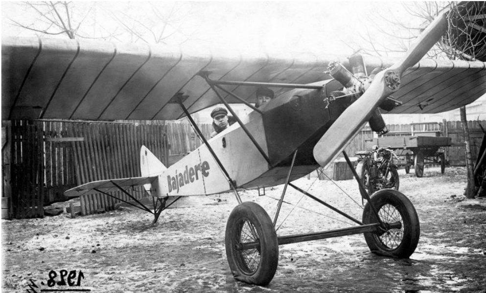
*Das Musterflugzeug der Hüffer „Bajadere“ in seinem letzten Rüstzustand mit dem Siebenzylinder-Rotationsmotor Typ Gnome Omega (50 PS, 37 kW). Ort und Zeitpunkt des Fotos sind unbekannt, ebenso die Herkunft der sehr laienhaft auf der Negativrückseite angebrachten Jahreszahl 1928.*
