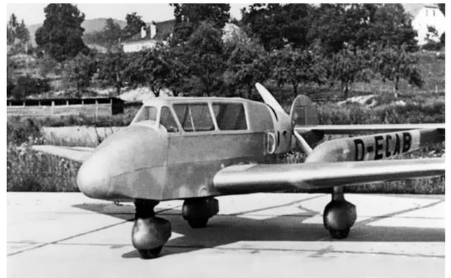
Nach Aufhebung des Flugzeugbauverbots in Deutschland wollte Hüffer die Fertigung des Motorflugzeugs Meindl-van Nes A-XV aufnehmen. Den Prototyp dieser Maschine hatten die Wiener-Neustädter Flugzeugwerke WNF 1939/40 unter der Bezeichnung Wn 16 in Österreich hergestellt. Zum Antrieb diente zunächst ein Sternmotor Salson AD 9, 1942 wurde das Flugzeug auf den Reihenmotor Walter „Mikron“ umgestellt.
