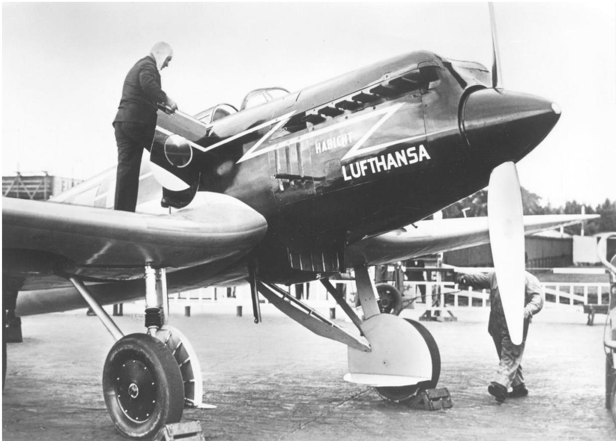
*Von Tempelhof aus bediente die Lufthansa mit der He 70 D, hier die D-UDAS, mehrere Schnellstrecken. Die spiegelnde Oberfläche der Zelle dokumentiert ihre extreme Oberflächengüte. Die D-UDAS ging im Januar 1935 bei einem Unfall in der Nähe von Konstanz verloren.*
