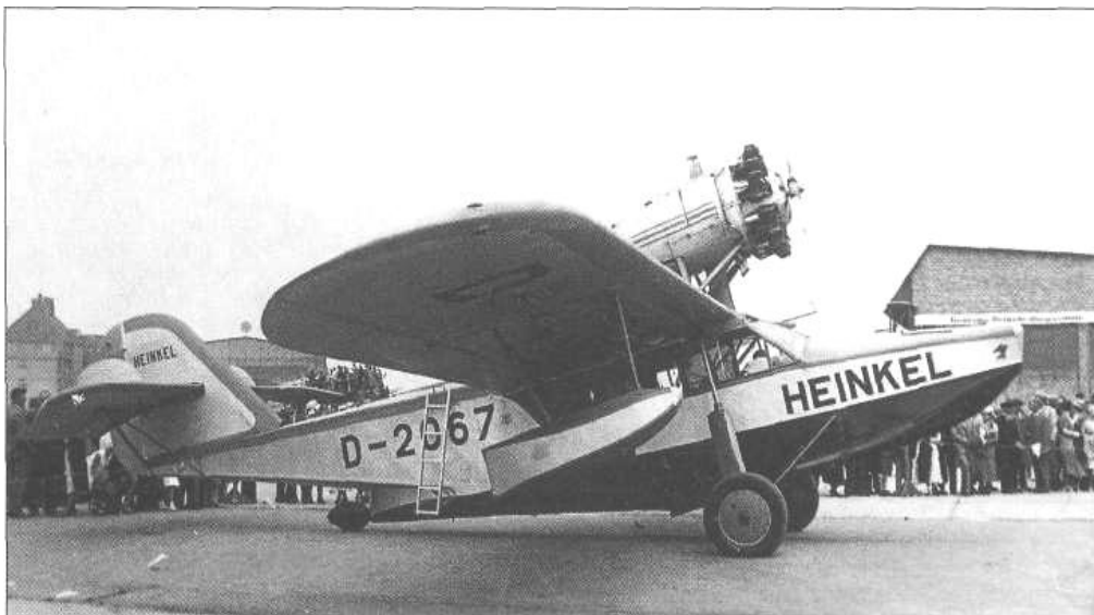
Erneut umgebaut mit Heckrad und zusätzlichen Stabilisierungsflächen auf der Höhenflosse wird die HE 57 am 2. August 1931 auf dem Flugtag in Warnemünde vorgeführt
