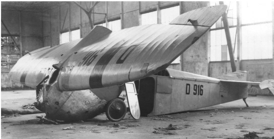
*Am 22.7.1926 warfen starke Windböen die D-916 bei der Landung in Norderney auf den Rücken. Wie auf dem Foto gut erkennbar, brach der Rumpf zwischen Führersitz und Kabine durch. Zum Glück befanden sich keine Passagiere an Bord. Die Maschine wurde trotz des "Genickbruchs" wiederaufgebaut und flog noch bis zum Beginn der dreißiger Jahre im Dienst der NILU.*
