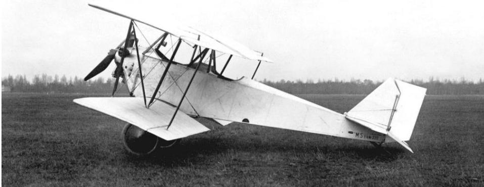
*Zweisitziger Schul-Doppeldecker Mark MS II b, Werknummer 220. Das Flugzeug trägt noch keine Zulassung, deshalb sind die Bilder vermutlich vor Oktober 1925 beim Stahlwerk Mark in Breslau entstanden.*
