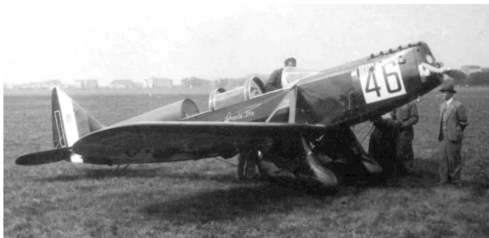
Bei der Anlaßprüfung verloren die Italiener wertvolle Punkte, weil ihre Motoren noch per Kurbel angedreht werden mußten. Die Breda BA 39 S, I-LUDO, wurde von Ernesto Sanzin geflogen.
