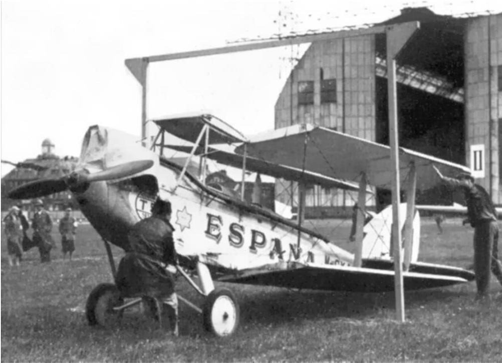
Der spanische Erzherzog Antonio Habsburgo-Borbón mit seiner De Havilland DH 60 G „Moth“ M-CKAA (T5) beim Erledigen des Prüfungspunktes „Ab- und Wiederaufrüsten“. Dabei mußte das Flugzeug so weit abmontiert werden, daß es durch ein Tor von 3,50 x 3,50 m paßte, und anschließend wieder flugfertig aufgerüstet werden. Die ganze Aktion durfte nicht länger als 20 Minuten in Anspruch nehmen.
