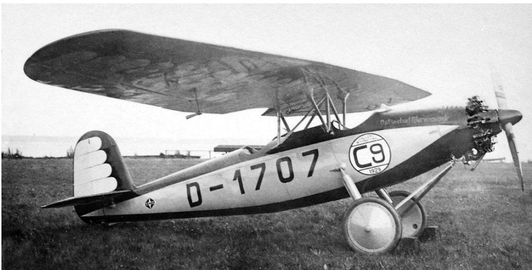
*Die bei Arado in Warnemünde gebaute L I, eine Eigenkonstruktion von Dipl.Ing. Hermann Hofmann, war aerodynamisch sehr gut durchgebildet.*
