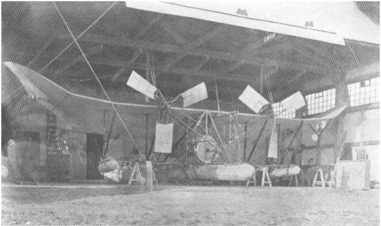
*Der große Wasser-Eindecker von August von Parseval im Schuppen der Flugstation am Plauer See in Mecklenburg 1910. Die schlauchbootartige Konstruktion des Rumpfes und der Seitenschwimmer und die Luftschauben erinnern an die Bauweise der unstarren Parseval-Luftschiffe.*
