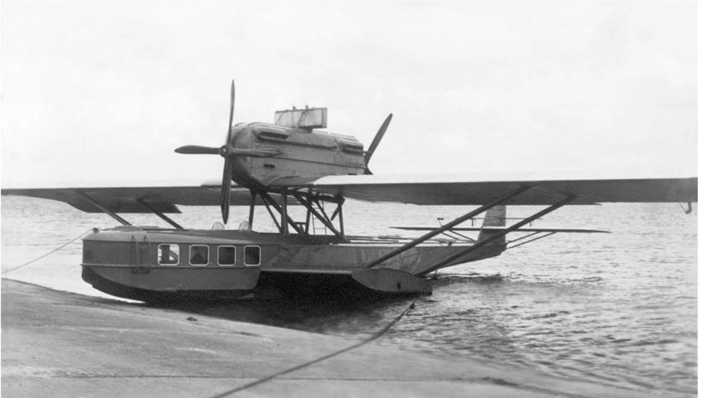
*Der Verkehrs-„Wal“ war durch die großzügige Kabinenverglasung im vorderen Rumpfbereich sowie den nach hinten verlegten Führerraum gut von der Militärausführung zu unterscheiden. Als Antrieb kamen überwiegend Rolls-Royce „Eagle“-Motoren zum Einbau. (Slg. Koos)*
