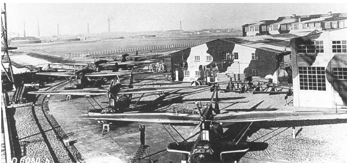
Eine Reihe fertiger Do 18 G bei Weser (Werk Einwarden), vermutlich aufgenommen kurz nach Kriegsbeginn, wie man aus der Tarnung der Gebäude schließen kann. Die Verbreiterung der Flossenstummel um 30 cm nach außen ist hier gut zu erkennen.
