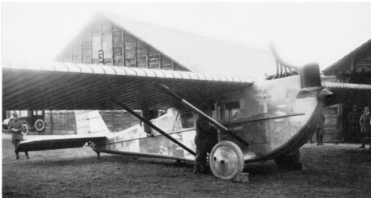
Schweizerischer Flugplatz Dübendorf, Flugerprobung der Dornier „Komet“ (WNR. 22) im Februar 1921. Der Einstieg in die Kabine war bei dieser Maschine reichlich unbequem, weil er sich zwischen den beiden Flügelstreben befand.
