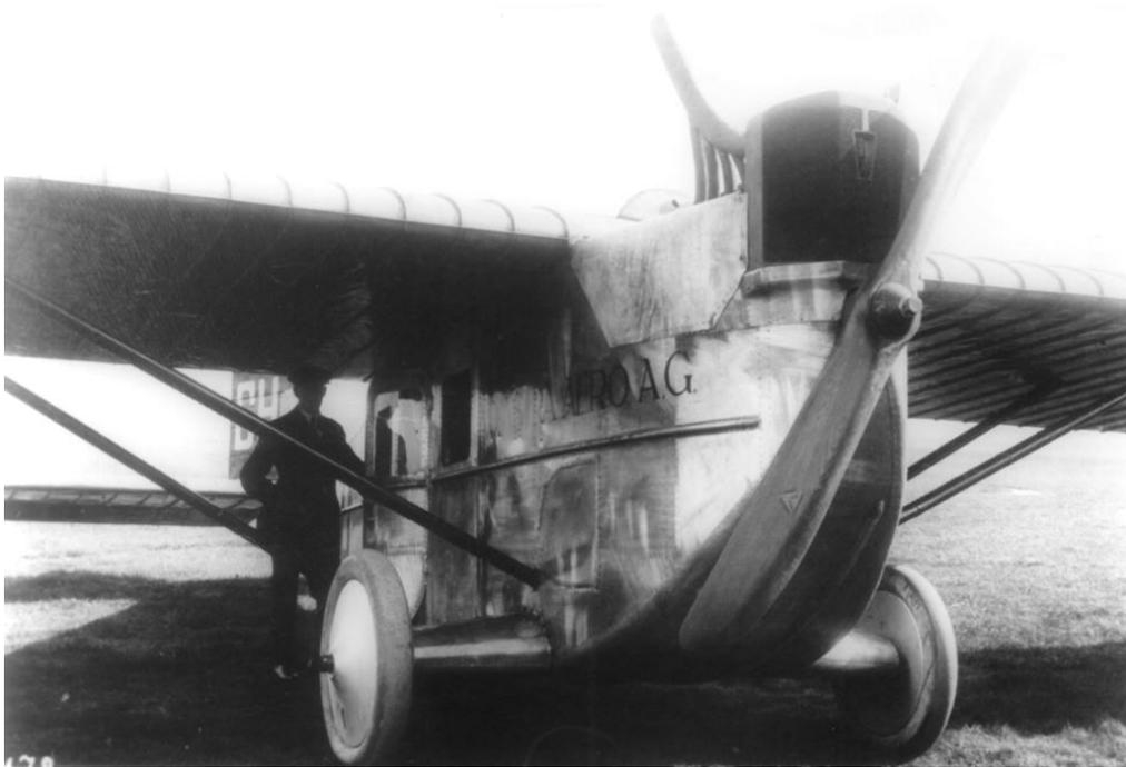
*Bugansicht der Dornier „Komet“ CH 50 im Einsatz bei der schweizerischen Fluggesellschaft AD ASTRA AERO AG. Die Triebwerkanlage bestand aus einem Sechszylinder-BMW III a, welcher auf einen Zweiblatt-Holzpropeller der Firma Hugo Heine wirkte.*
