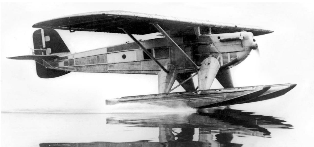
Die Werknummern 193 und 194 der zweiten Jugoslawien-Baureihe erhielten anstelle der Hosenbeinverkleidungen vier schlanke Beine als Schwimmerabstützung. Diese Änderung brachte eine Verbesserung des Kurvenverhaltens, führte aber zu einem merklichen Geschwindigkeitsverlust infolge stärkerer Wirbelbildung und wurde deshalb nicht weiter verfolgt. (oberes Bild: Slg. Koos, unteres Bild: EADS, Historisches Unternehmensarchiv Dornier, Immenstaad)
