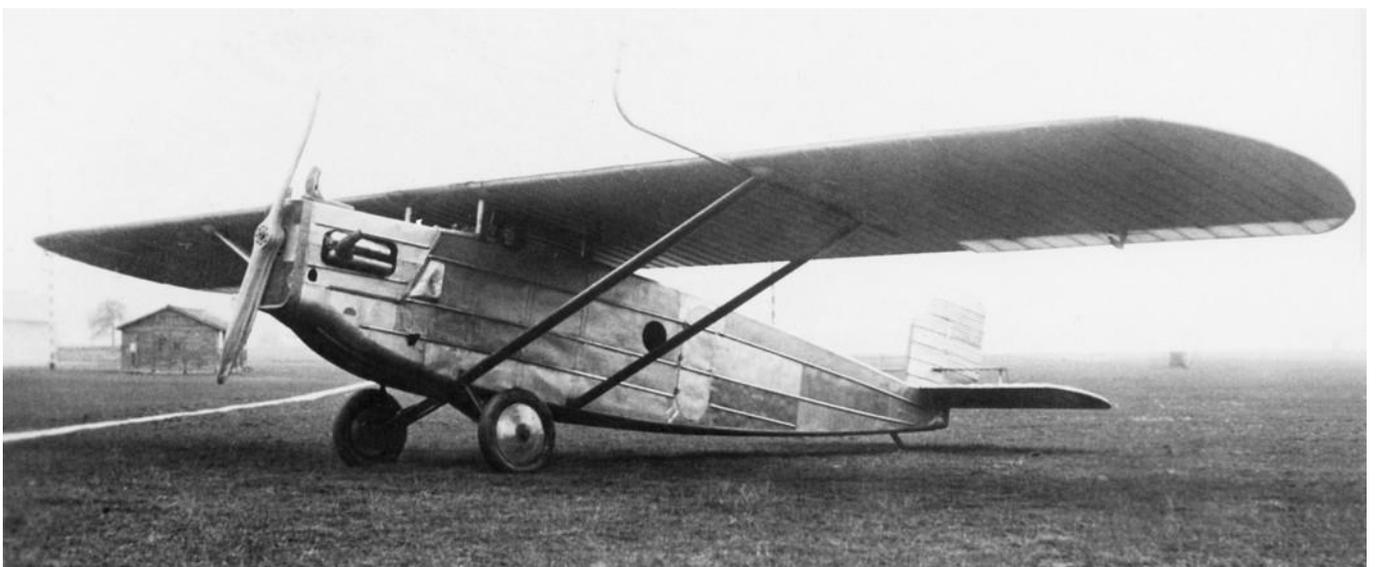
Die Motorpartie der zweiten Do C (Werknummer 62) erhielt nach dem Einbau des Napier „Lion“-Triebwerks ein erheblich gedrungeneres Aussehen. Die hosenartigen Fahrgestell-Verkleidungen kamen zum Fortfall.
