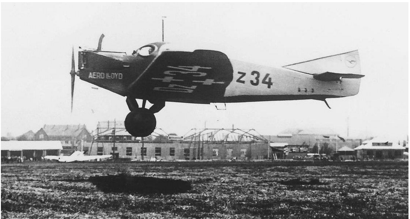
Die Junkers F 13, Dz 34, des Danziger Aero-Lloyd landet 1925 auf dem Flugplatz Böblingen. Die Unterseiten von Flügel, Rumpf und Höhenleitwerk sind in schwarzer Bitumenfarbe bemalt. Auf der Motorhaube prangt jetzt der neue Firmenschriftzug, aber nicht mehr der Taufname der Maschine..
