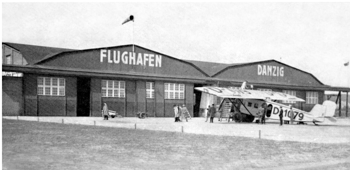
Die große Flugzeughalle in Langfuhr mit den zur Flugfeldseite hin zeigenden, charakteristischen Knickgiebeln über den beiden großen Schiebetoren. Auf dem Hallenvorfeld steht ein Dornier „Merkur“ der deutsch-russischen Fluggesellschaft DERULUFT.
