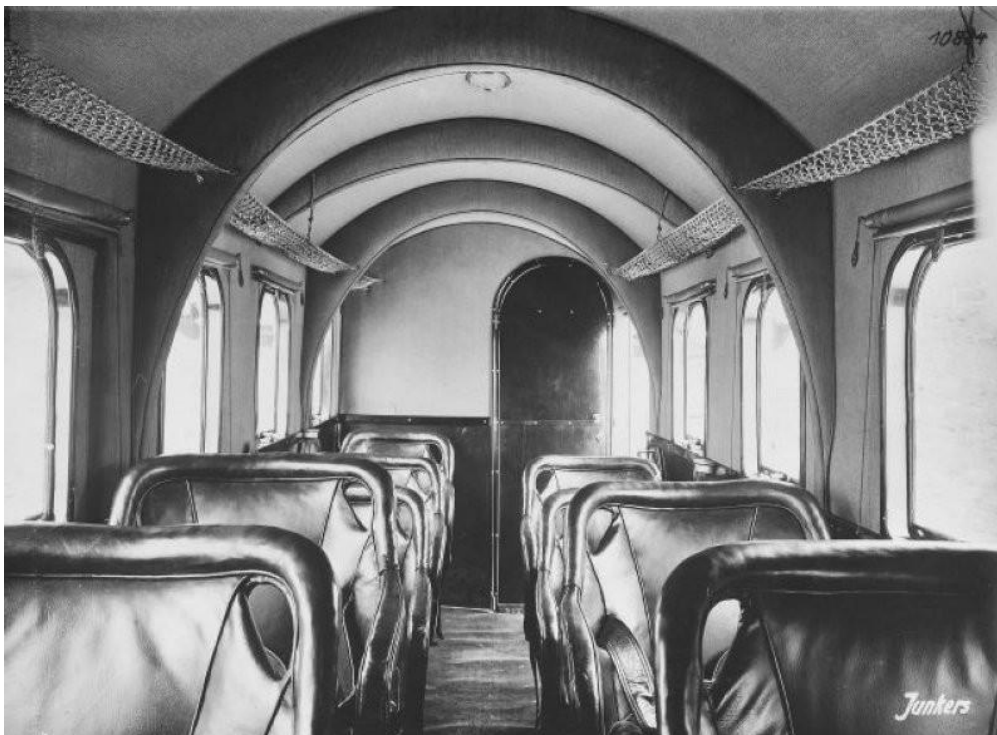
(oben): Junkers G 24, Werknummer 843, Zulassung S-AAAK, Junkers-Name „Mecklenburg“. (unten): Passagierkabine der G 24 mit neun bequemen Einzelsitzen. Die Tür an der Rückwand führte zum Waschraum und zur Bordtoilette.
