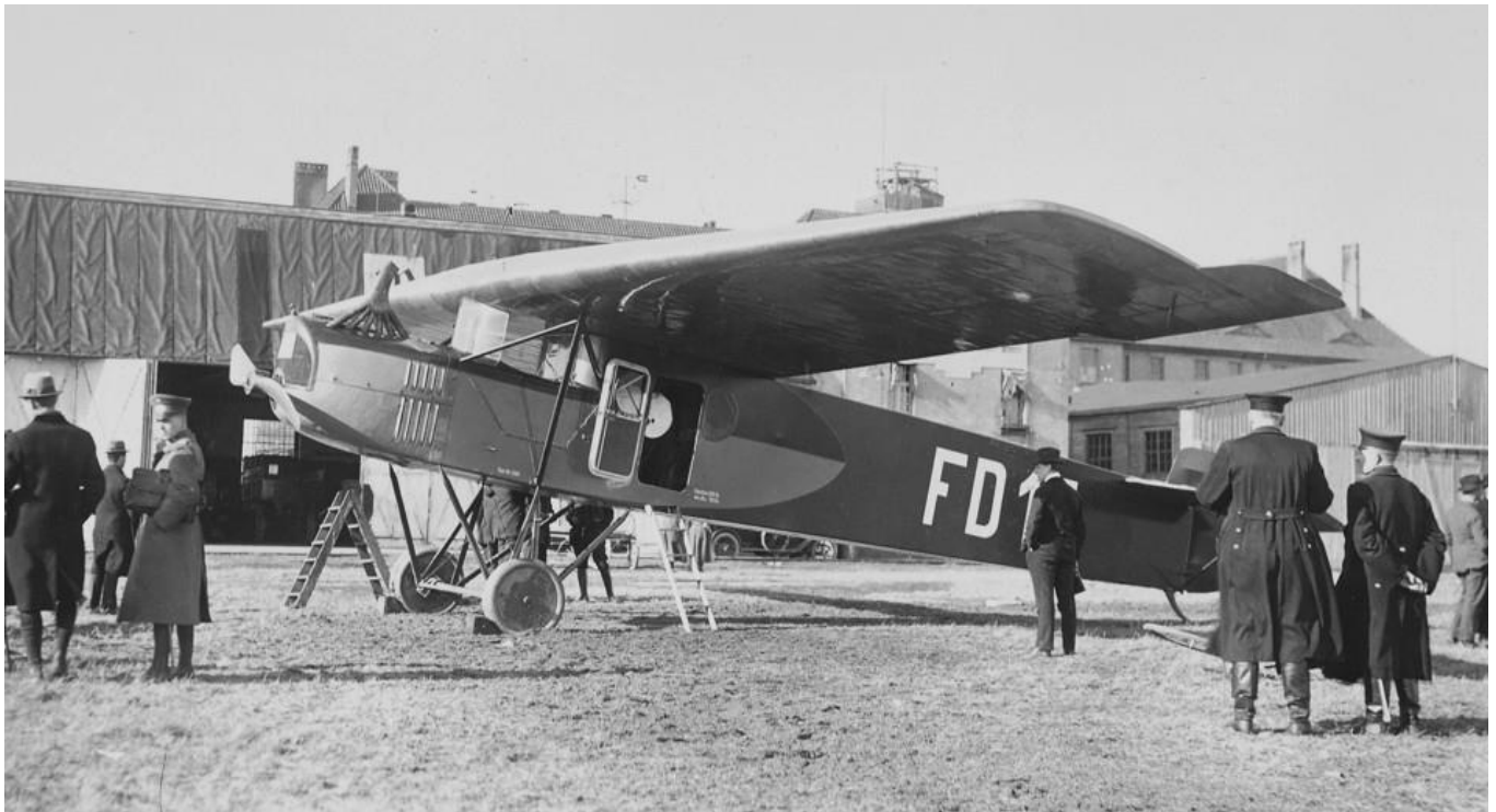
Die vordere Hälfte des Rumpfes der FD 15 war in den Farben schwarz und gelb lackiert, der Farbton der hinteren Rumpfpartie ist nicht überliefert. Die Flügel trugen eine Stoffbespannung mit aufgedruckten militärischen Tarnfarben, wie sie in den letzten Kriegsjahren ballenweise hergestellt wurden.
