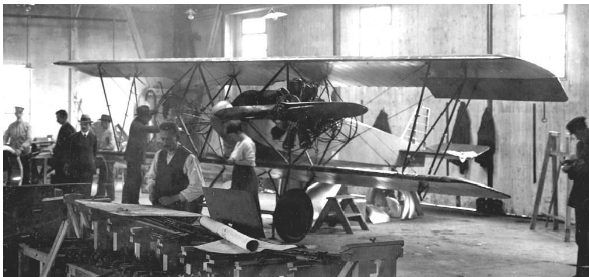
(oben): Blick in die HFC-Versuchsabteilung mit dem im Bau befindlichen zweimotorigen Jagdflugzeug.
