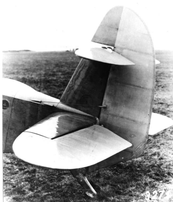
Leitwerk der C 32 mit zusätzlicher Trimmflosse.
