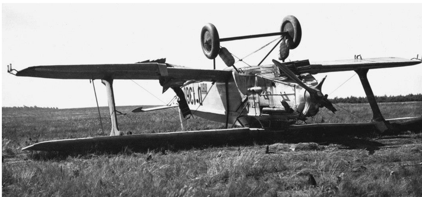
Am 2. Juli 1930 mußte die D-1360 in der Letzlinger Heide nahe dem kleinen Ort Dolle notlanden, weil das BMW-Triebwerk streikte. Dabei überschlug sich die Maschine aufgrund des ungünstigen Geländes und erlitt so große Schäden, daß sich ein Wiederaufbau nicht lohnte. Die Besatzung blieb zum Glück unverletzt. (beide Bilder: Slg. Ott/ADL)
