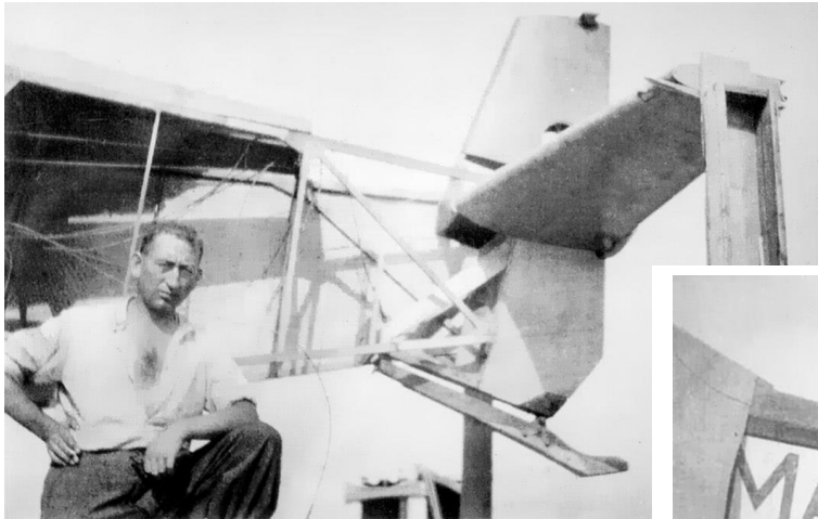
Nach dem Startunfall der „Germania“ am 30.9.1927 in Bagdad wurde die Maschine in der britischen Militärwerft Bagdad-Hinaiidi binnen einer Woche wieder hergerichtet, einschließlich einer Neuanfertigung des Leitwerks.
