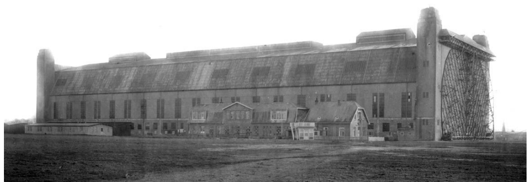
Gesamtansicht der großen Zeppelinhalle, des sog. Betriebs B und C, von Norden.
