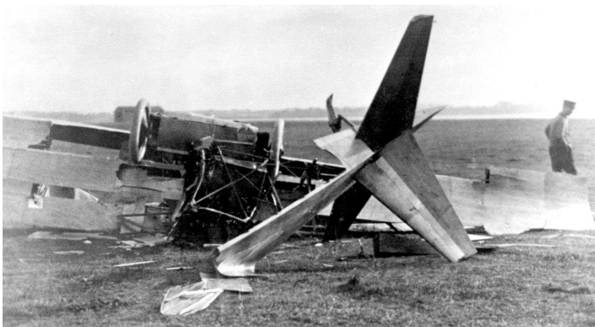
Absturz der Caspar C 14, Version 2, am 18.10.1924 bei einem Probeflug in Travemünde. Flugzeugführer Weichelt erlitt Verletzungen am Kopf und an den Beinen.
