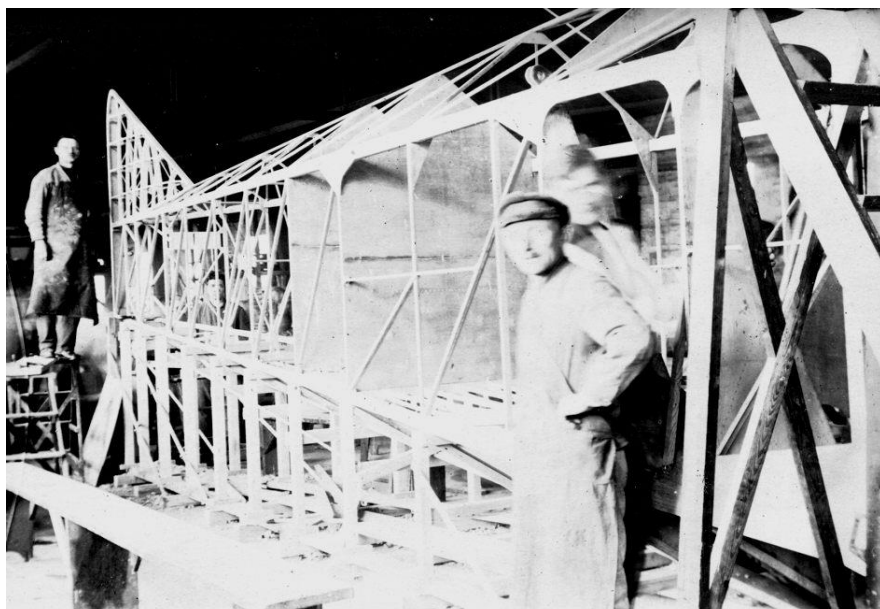
Das Rumpfgerüst der Caspar CLE 12 im Rohbau. Die Lage der Passagierkabine ist bereits zu erahnen.
