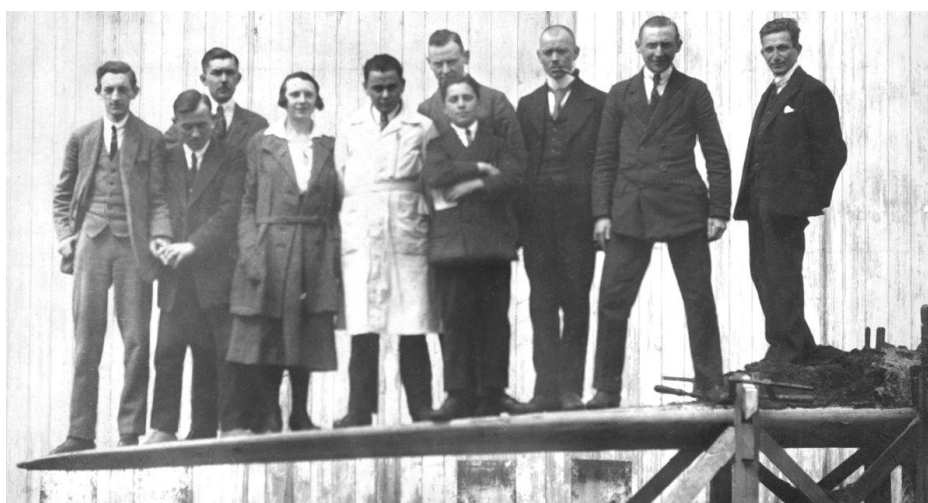
Belastungsprobe der besonderen Art für eine Tragflügelhälfte der Caspar U 1. Ganz links auf der Flügelspitze steht Ing. Richard Bauer, Konstrukteur bei den Caspar-Werken.
