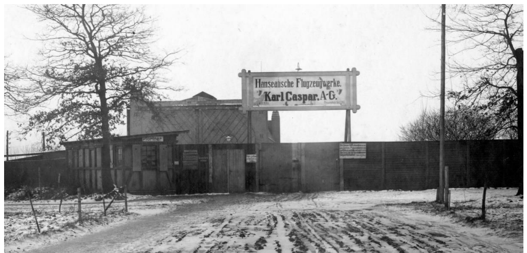
Eingangstor zu den Werksanlagen der HFC in Hamburg-Fuhlsbüttel.
