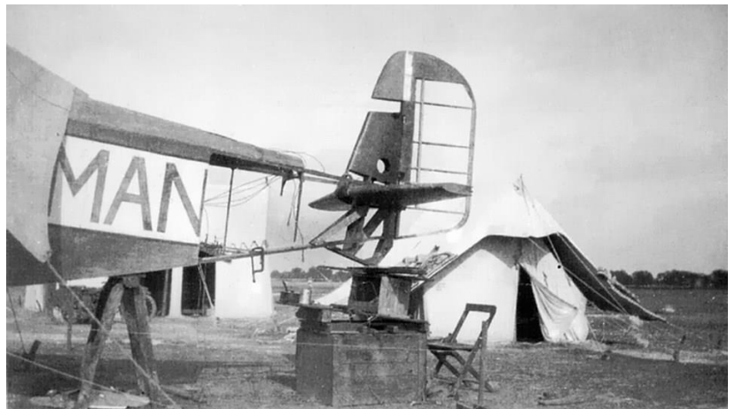
Nach dem Startunfall der „Germania“ am 30.9.1927 in Bagdad wurde die Maschine in der britischen Militärwerft Bagdad-Hinaiidi binnen einer Woche wieder hergerichtet, einschließlich einer Neuanfertigung des Leitwerks.
