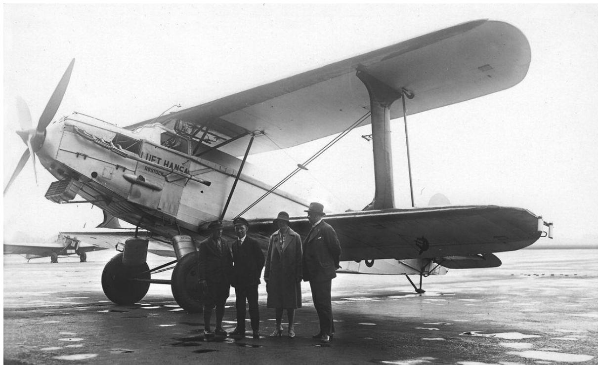
*Die Caspar C 35 D-1360 blieb ein Einzelexemplar und flog bei der Luft Hansa in den Jahren 1929 und 1930 ausschließlich als Frachtflugzeug. Auf diesem Bild fällt die veränderte Abgasanlage des Motors auf, deren Rohr nun bis hinter die Flugzeugführerkabine reichte, um eine Beeinträchtigung der Piloten durch Abgasdämpfe zu minimieren. (Slg. Ott/ADL)*
