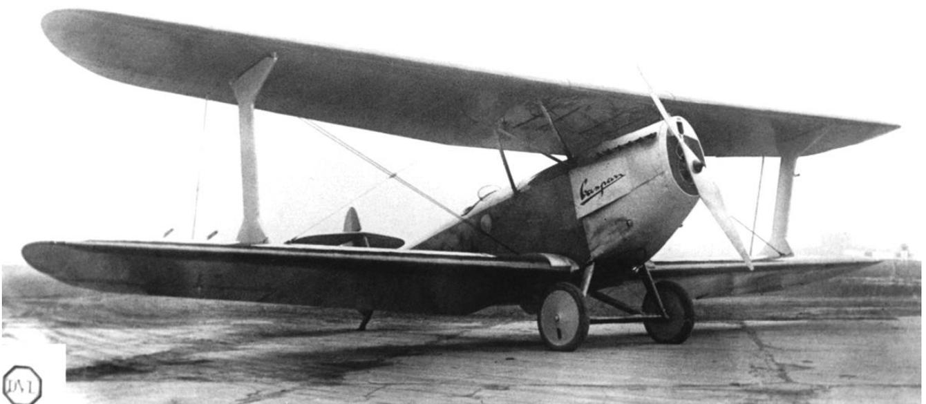
*Die C 32 Werknummer 7009 (ehemaliges Kennzeichen D-1144) erhielt im Herbst 1927 Flügel mit vergrößerter Spannweite und teilweiser Sperrholzbeplankung sowie I-Streben aus Duralumin. Die offizielle Bauabnahme der nun mit Caspar C 34 bezeichneten Maschine erfolgte am 13.11.1927 bei der DVL in Berlin-Adlershof. Dabei entstand dieses Foto.*
