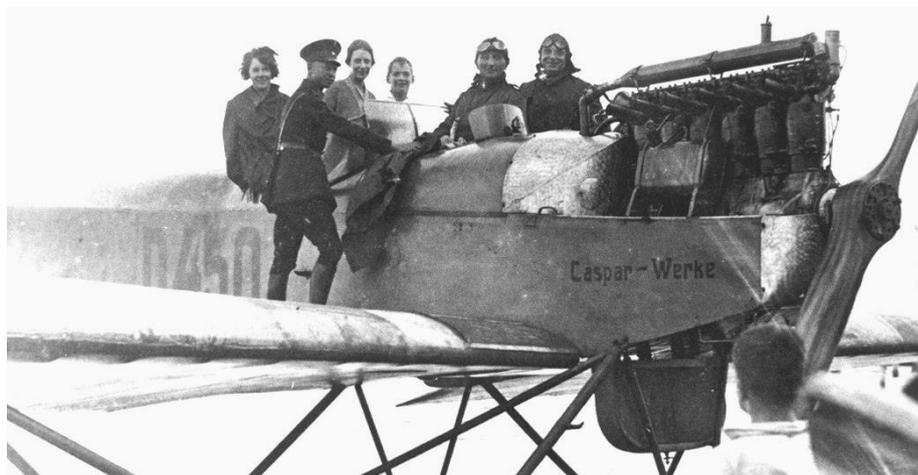
*(links und unten): Auf diesen Fotos ist bereits der Mercedes D IV a in die D-450 eingebaut und der hohe Stirnkühler hat einem flachen Bauchkühler weichen müssen. Die neue gerundete Verkleidung der oberen Rumpffront hinter dem Motor läßt vermuten, daß die Maschine nur noch mit freiliegendem Triebwerk geflogen wurde. Als Pilot ist auf dem linken Bild wieder Franz Sido im Einsatz.*
