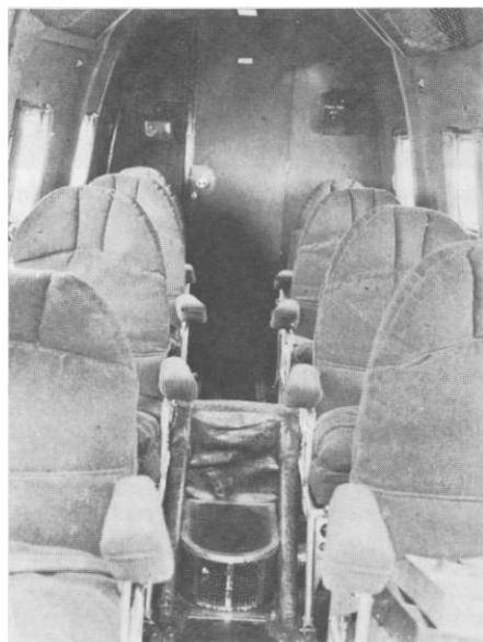
Die zehnsitzige Kabine der D-AGAR war komfortabel und zweckmäßig eingerichtet. Der durch den Rumpf geführte Tragflächenholm wurde geschickt mit einer als Warmluftaustritt ausgebildeten Stufe kombiniert. (Foto: Lufthansa)
