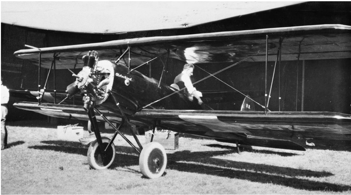
Die Pausen zwischen den Rundflugschleifen in Tempelhof wurden für Überholungsarbeiten am „Alsterkind“ genutzt. Alle Verstrebungen und Stiele, selbst die Fahrgestellfelgen, sind mit Siegeln bzw. Farbmarkierungen versehen, um ein unerlaubtes Auswechselln dieser Teile während des Streckenflugs zu verhindern. (Album Bäumer)
