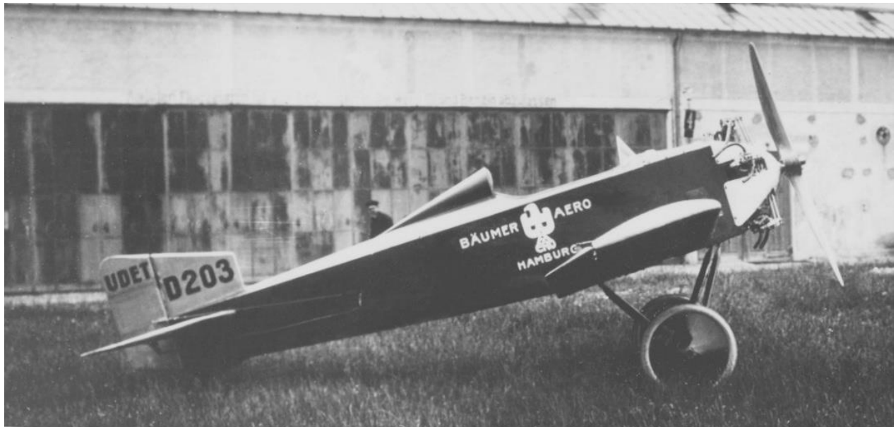
Nach mehreren Udet U 2 erhielt die Bäume Aero für ihren Vorführpark auch eine der wenigen gebauten Udet 4. Dabei handelte es sich um eine Weiterentwicklung des Musters U 2 mit einem deutlich stärkeren Triebwerk – nämlich dem Fünfzylinder-Sternmotor Siemens Sh 4 (Leistung 55/60 PS, 40/44 kW). Die Maschine trug das Kennzeichen D-203 und wurde am 31.05.1923 durch Paul Bäumer von Fürth nach Hamburg überflogen. (Foto EADS)
