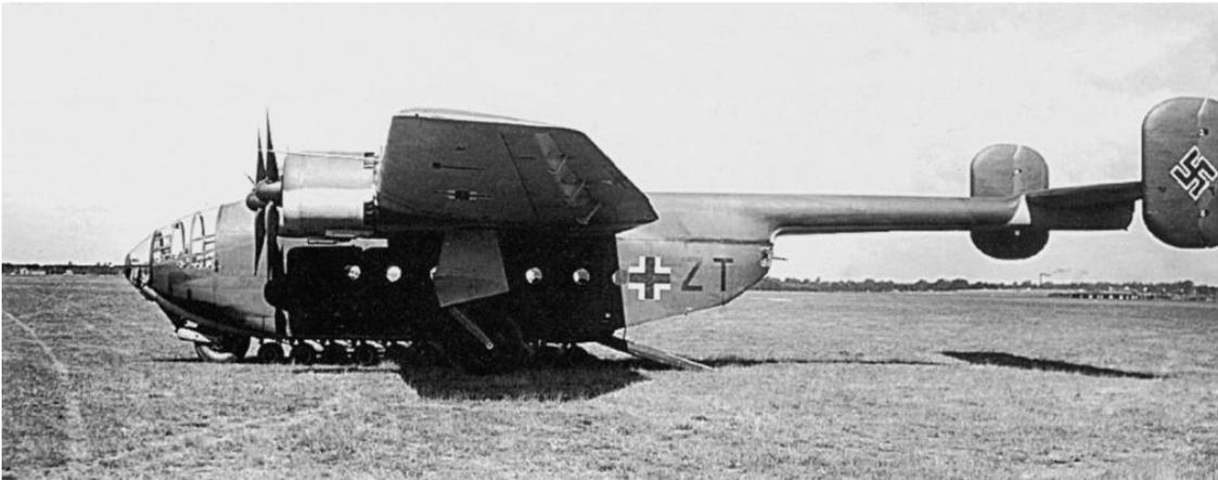
*Seitenansicht der Ar 232 B-01 KI+ZT. Gut zu sehen ist die heruntergeklappte Laderampe zur Aufnahme des Transportguts.*
