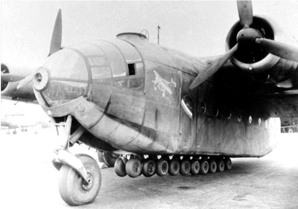
*Ar 232 B-0 der 7./Erg.TG. mit abgesenkten Hauptfahrwerksfederbeinen, aber ganz ausgefahrenem Bugrad. In diesem Zustand war ein verhältnismäßig leichtes Beladen mit Frachtgut aller Art über die herunterklappbare Laderampe im Heck möglich.*
