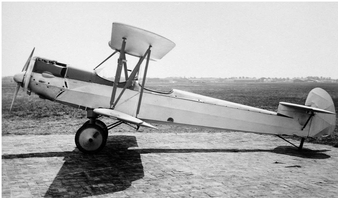
Das fertige Musterflugzeug Albatros L 82 mit De Havilland „Gipsy“-Motor, Werknummer 10158, in voller Lackierung, aber noch ohne Zulassung, Beschriftungen und sonstige Embleme. Die Aufnahme dürfte im Juni/Juli 1929 entstanden sein. (Slg. Koos/ADL und Ott/ADL)
