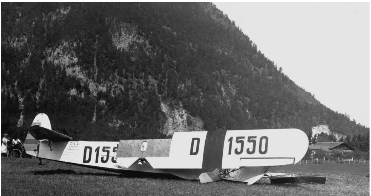
Bruchlandung der Albatros L 75 a, Zulassung D-1550, am Rand des Flugplatzes Bad Reichenhall wegen Motoraussetzer. Das Flugzeug gehörte zum Bestand der DVS Schleißheim und hatte den Auftrag, in Bad Reichenhall eine Meldung abzuwerfen. (diese Seite und nächste Seite oben)
