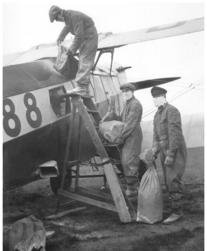
(links): Schema der HLV-Zerstäubungsanlage in den beiden L 72 b. (oben): Befüllung des Streugutbehälters der D-888 mit dem Kontaktgift „Hestha“ durch die runde Öffnung in der oberen Rumpfschräge. Die Arbeiter tragen zur Sicherheit alle Atemschutz. Neben der Stehleiter ist der rechte Ausblasestutzen vom Windkanalsystem der Zerstäubungsanlage zu erkennen. (links Slg. Ott, rechts Slg. Frost)
