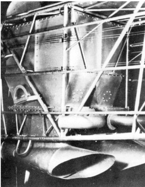
Eine Heinkel He 45 D wurde im Herbst 1939 bei der Abt. Schädlingsbekämpfung des Flugkommandos Berlin mit der aus einer Albatros L 72 stammenden HL V-Streuanlage ausgerüstet. (Slg.Ott)
