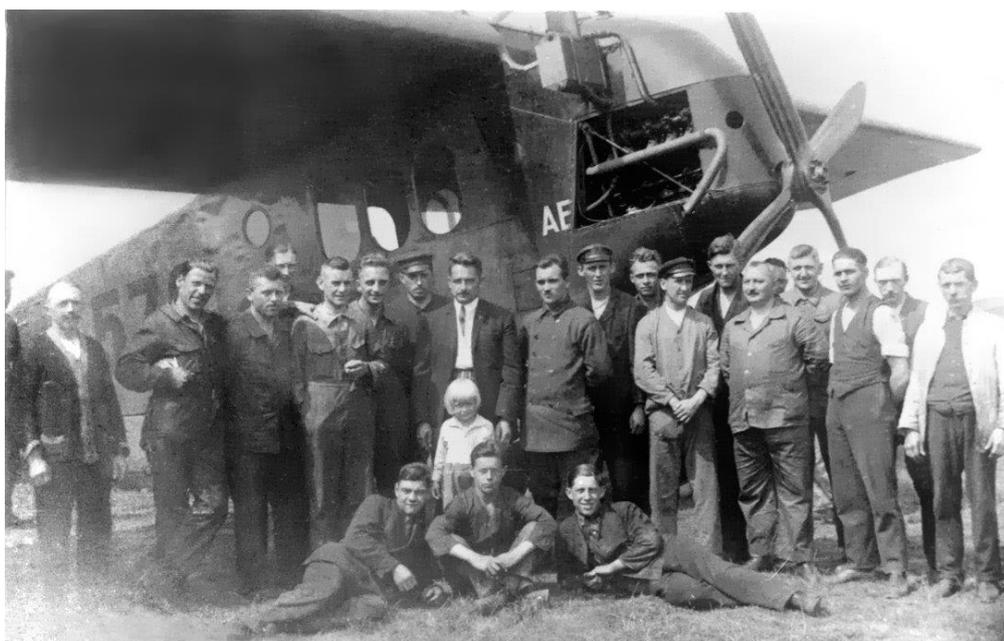
*Die Albatros L 58 D-576 im Jahr 1925 beim Deutschen Aero-Lloyd. Das Flugzeug hatte für den Einbau des stärkeren und schwereren Motors Rolls-Royce-„Eagle VIII“ einen neuen Vorderrumpf bekommen, basierend auf einem Stahlrohrfachwerk. Wie schon die D-297, hatte auch die D-576 nur noch eine Kabinentür, und zwar auf der linken Rumpfseite. Hinter dem kleinen runden Fenster auf der rechten Seite befand sich ein Toilettenraum.*
