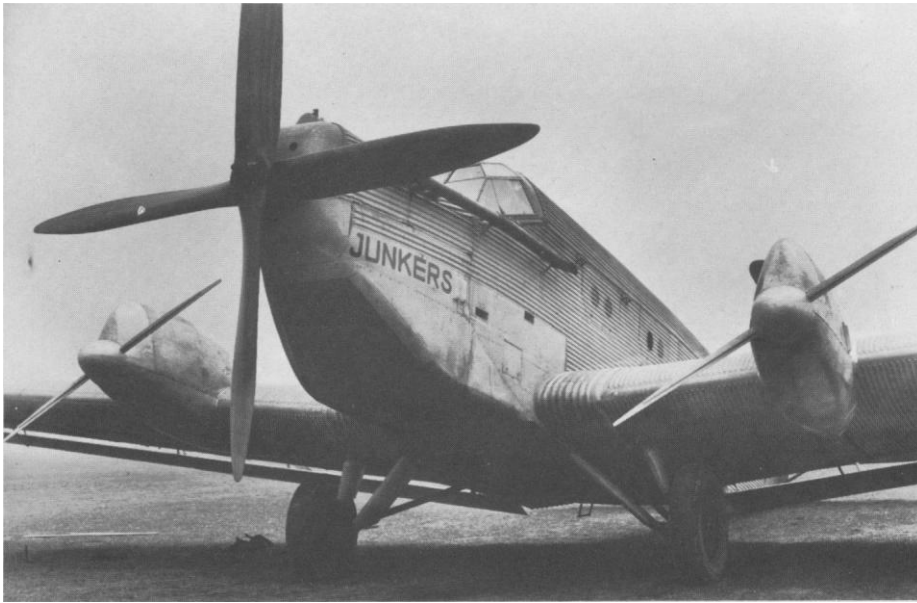
Auf Anregung der Luft Hansa wurden im April 1931 die Möglichkeiten einer dreimotorigen Ausführung untersucht. Die Werknummer 4001 erhielt Seitenmotor-Attrappen zur Durchführung von Leistungs- und Beeinflussungsmessungen.
