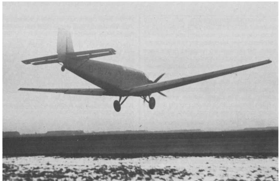
Mit 70-80 km/h setzte die Ju 52 bei D-1974 zur Landung an. Der gesamte Hilfsflügel diente als Landeklappen.
